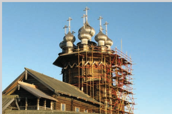
Реставрация кровли Покровской церкви
