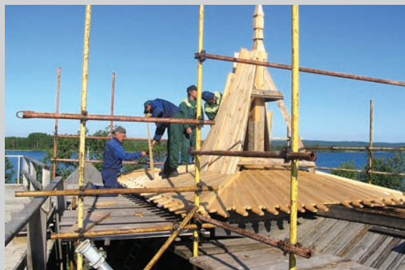
Реставрация северной башни ограды погоста
