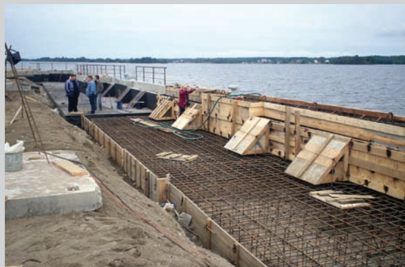
Строительство грузового причала на острове Кижы
