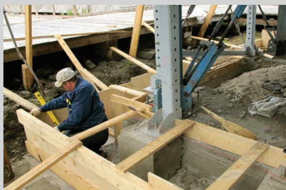
Монтаж опалубки для бетонирования подземной железобетонной части фундамента
