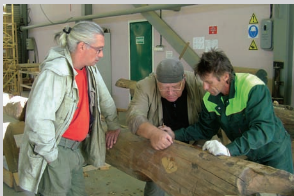
Реставрация бревен сруба церкви
