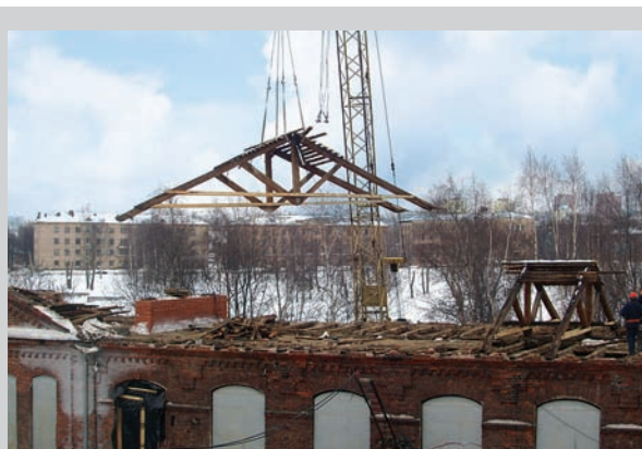
Фондохранилище музея в г. Петрозаводске: демонтаж кровли
