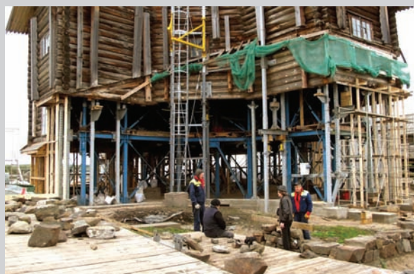
Закончено бетонирование фундамента и выложен экспериментальный участок кладки
