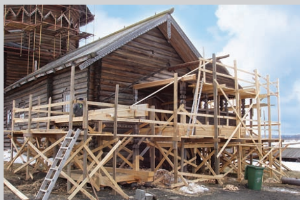
Реставрация крыльца Покровской церкви
