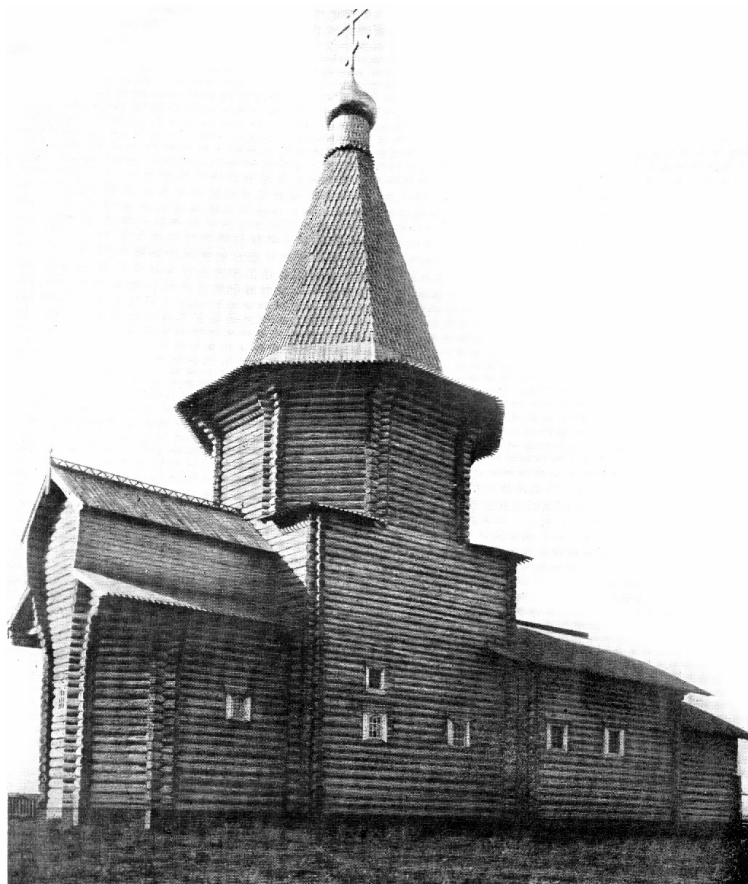
Рис. 6. Петропавловская церковь. 1698 (?). Село Пучуга. Верхне-Тоемский район Архангельской области
