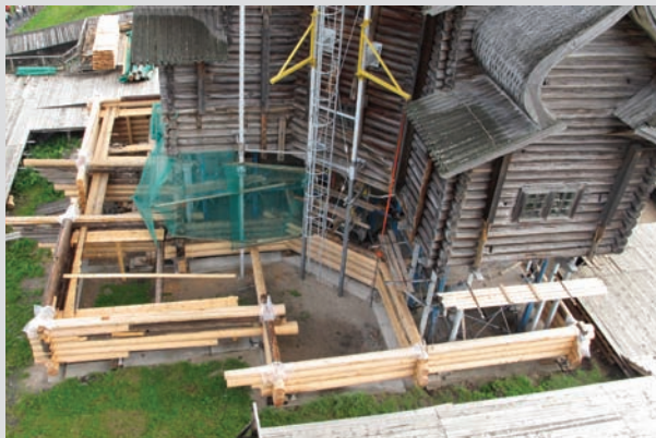
Сборка отреставрированного подклета Преображенской церкви. Июнь 2012 г.
