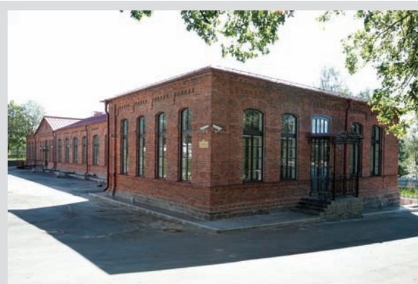
Здание бывших ремесленных мастерских (фондохранилище музея) после реставрации
