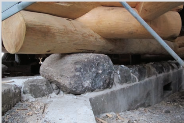
Угол сруба Преображенской церкви, установленный на фундаменте
