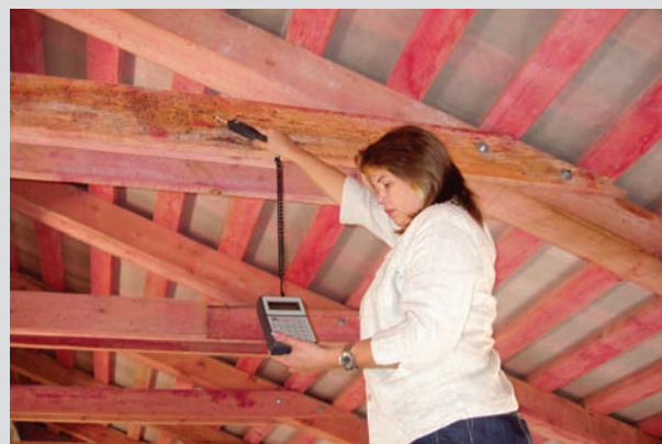
Контроль влажности деревянных конструкций
