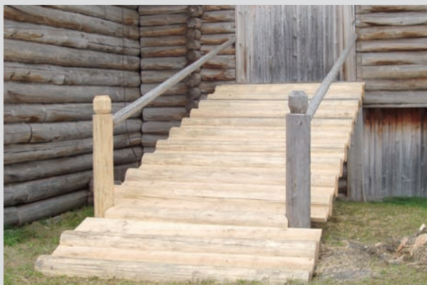
Отремонтированный взвоз дома Бутина (XIX — начало XX в.)
