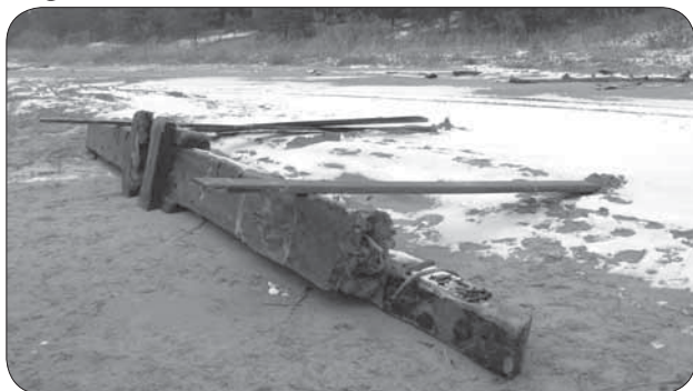
Кусок кильсона со степсом (фото автора, 2009 г.)
