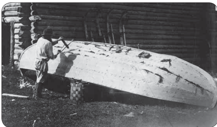
Рис. 5. Шитьё лодки корнем на озере Сязозеро (фото 1903 г.)
