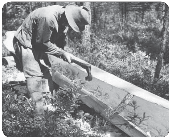
Рис. 29. Изготовление финской долблёной лодки с разведёнными бортами
