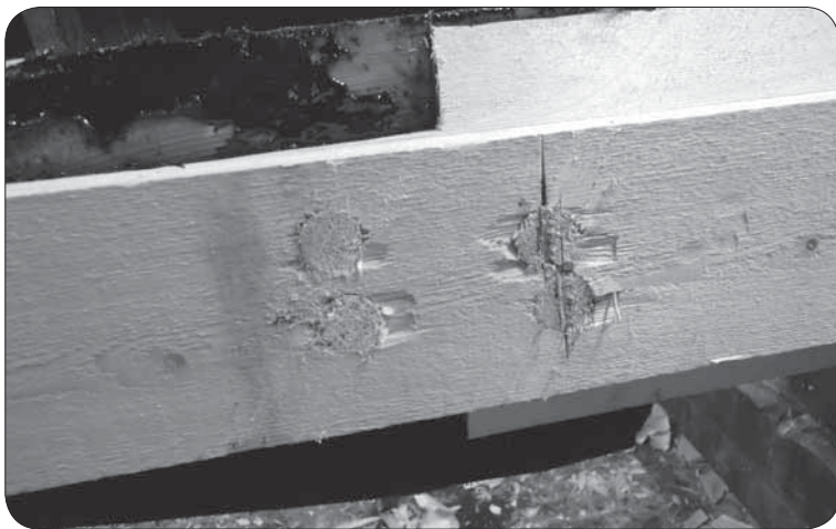
Закрепление «кокки» с килем на четыре нагеля – «таппи» (фото автора, 2011 г.)
