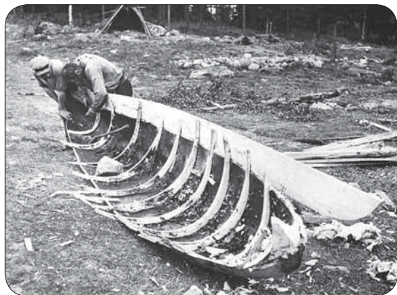
Рис. 30. Изготовление финской долблёной лодки с набойными бортами
