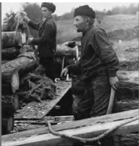
Справа: Вересов Иван Федорович во время реставрационных работ. 1980-е гг.
