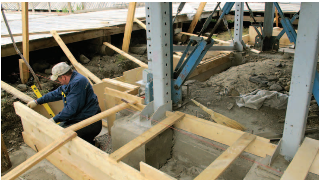
фото 1. Монтаж опалубки для бетонирования железобетонной части фундамента (подземная часть)
