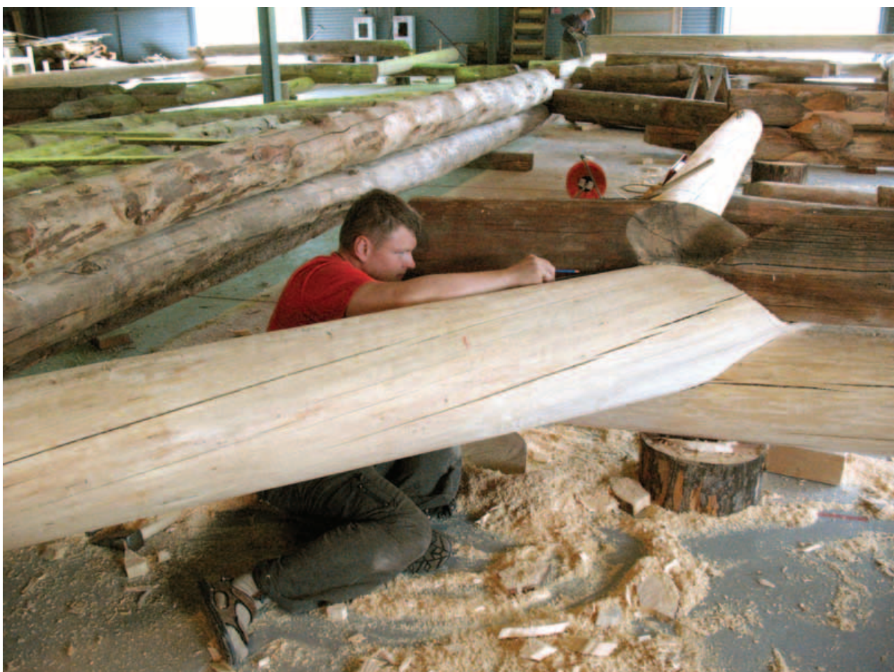
фото 10. Работа по тщательному совмещению старого и нового материала подкleta памятника
