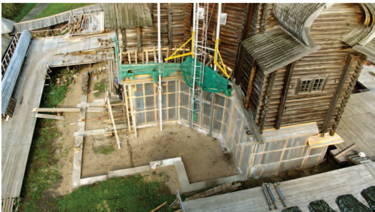
фото 4. Консарвация объекта на зимний период. Вид сверху подземной части фундамента трапезной.
