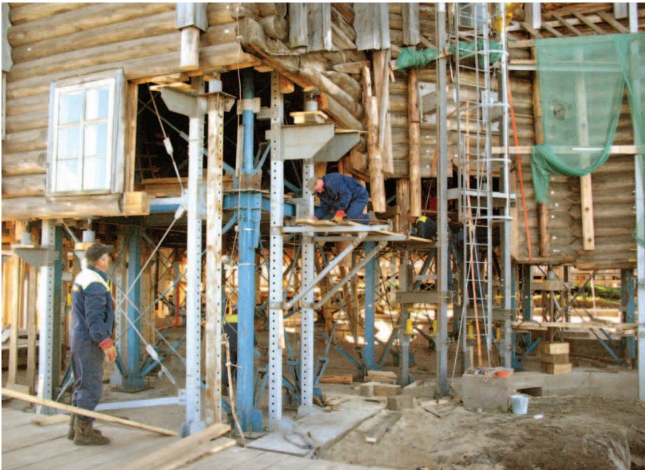
фото 5. Процесс демонтажа бревен церкви из сруба с помощью системы лифтинга
