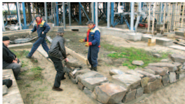
фото 9. Экспериментальный участок кладки видимой (надземной) части фундамента
