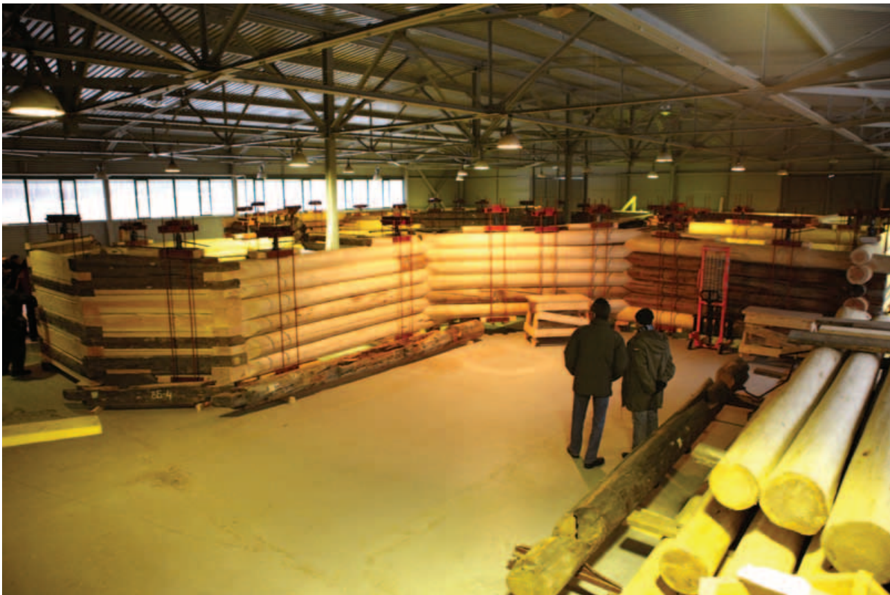
фото 13. Завершенный объем работ по реставрации подклета с нагрузкой на венцы сруба
