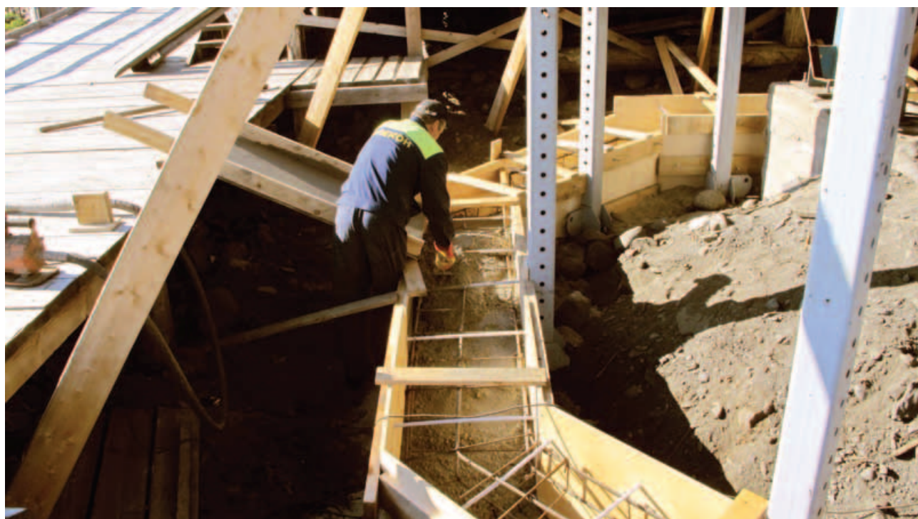
фото 2. Бетонирование ж/б части фундамента (подземная часть)
