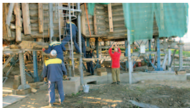
фото 10. Демонтаж элементов VII-го пояса и закрепление вывешенных стен на конструкциях лифтинга
