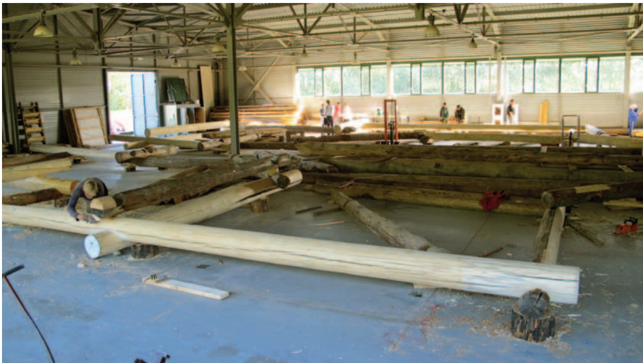
фото 9. Начало сборки подкleta памятника в новом откорректированном положении
