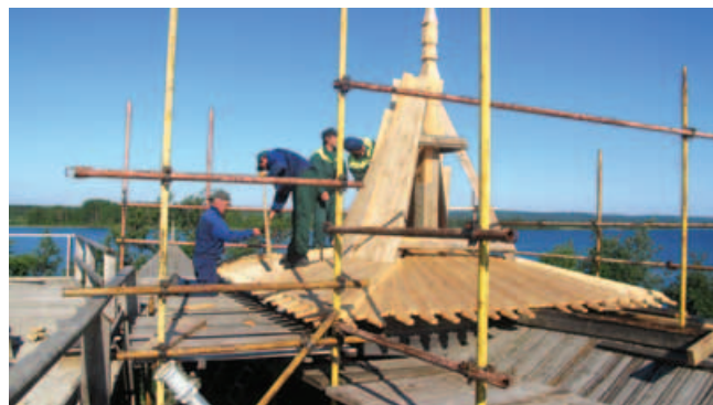
фото 23. Реставрация северной башни ограды погоста
