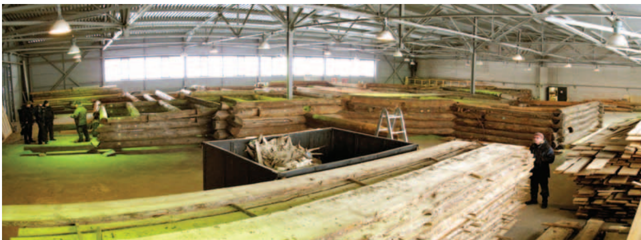
фото 12. Не отреставрированный сруб подклета церкви в новом откорректированном положении. Зима 2010-2011гг.
