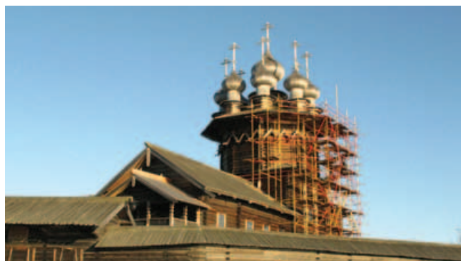
фото 22. Леса для завершения работ по реставрации кровли в 2011-2012гг.
