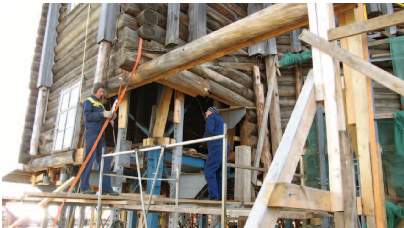
фото 6. Бревна демонтируют монтажники из ООО «СКФ «Алекон», работающие на церкви с 2004 года
