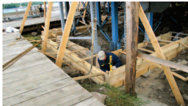
фото 7. Монтаж опалубки подземной части фундамента
