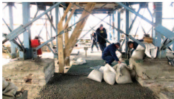
фото 8. Планировка грунта в подклете и укладка полимерной геосетки
