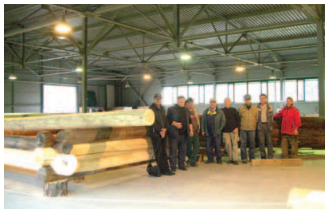
фото 13. Начало сборки подклета церкви на сборочной площадке комплекса
