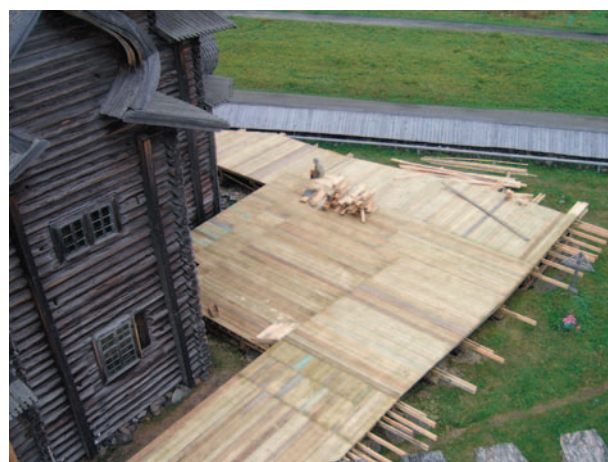
рис. 24. Строительство настила-эстакады вокруг церкви
