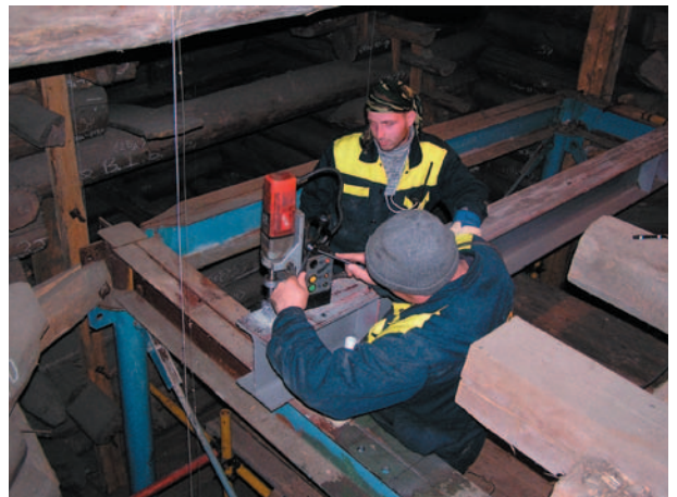
рис. 34. Монтаж конструкций лифтинга внутри церкви
