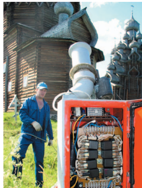
рис. 39. Модернизация дистанционно-управляемых лафетных стволов (ДУЛС) пожаротушения
