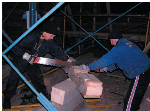
рис. 45. Монтаж подмостей внутри Преображенской церкви
