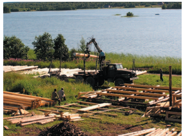
рис. 8. Укладка спецлеса в штабеля на острове Киж
