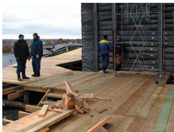
рис. 26. Строительство настила-эстакады вокруг церкви
