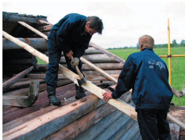
рис. 53. Работа сотрудников «Плотницкого центра» на объектах музея-заповедника
