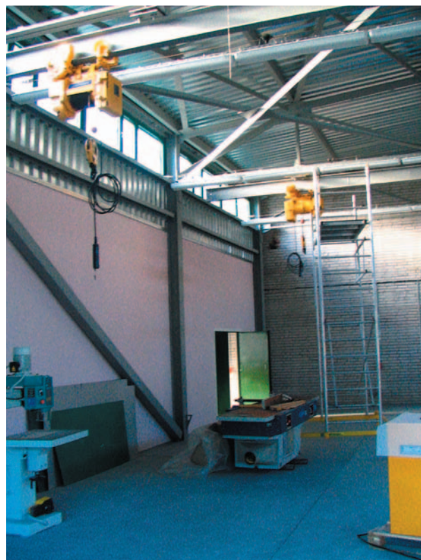
рис. 21. Монтаж оборудования в производственном корпусе
