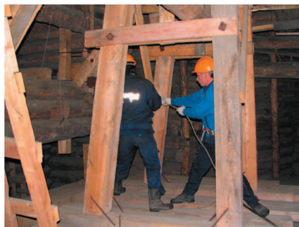
рис. 46. Участие «Плотницкого центра» в монтаже конструкций лифтинга
