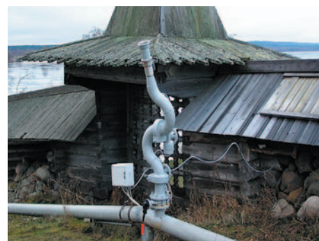
рис. 40. Общий вид дистанционно-управляемого лафетного ствола (ДУЛС)
