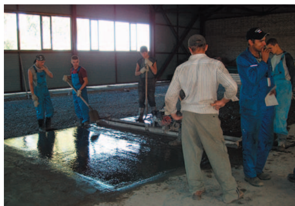
рис. 18. Заливка бетонных полов в корпусах комплекса
