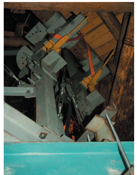
рис. 29. Фрагмент конструкций лифтинга I-го реставрационного пояса
