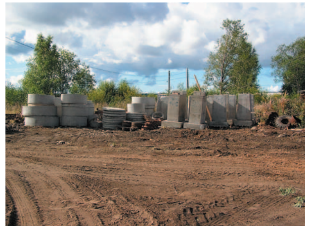
рис. 13. Завоз строительных материалов и конструкций
