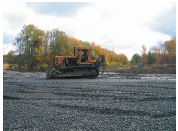
рис. 14. Строительство подъездных путей и выравнивание площадки
