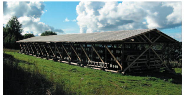
рис. 9. Склад-навес, построенный в 2004 году
