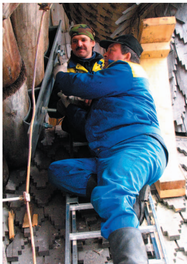
рис. 36. Монтаж ответных конструкций подъемных ползунов на наружных стенах церкви
