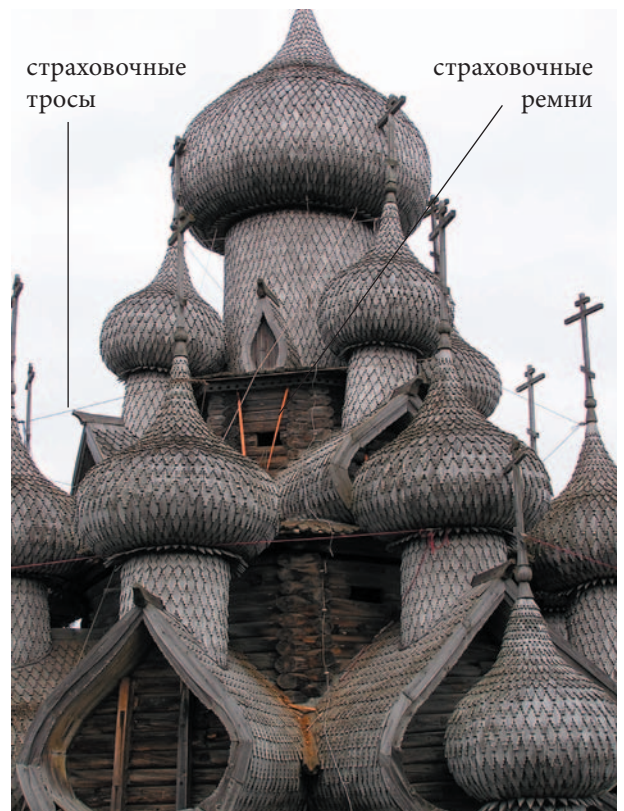
рис. 32. Страховочные мероприятия при подъеме-опускании
