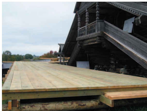
рис. 25. Строительство настила-эстакады вокруг церкви
