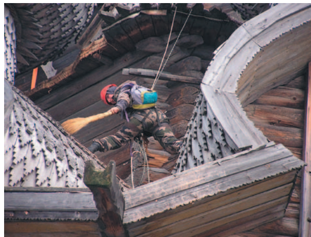
рис. 62. Очистка кровель Преображенской церкви от мусора
