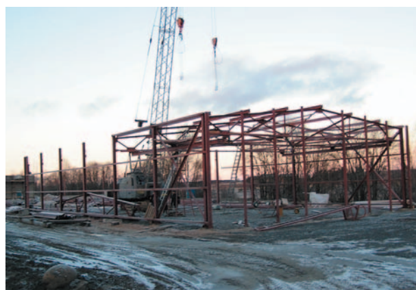
рис. 16. Монтаж корпусов реставрационного комплекса
