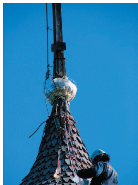
рис. 61. Проведение противоаварийных работ по укреплению оси центрального креста Преображенской церкви
