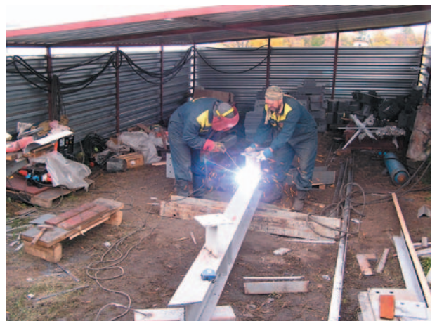
рис. 35. Подготовка металлоконструкций к монтажу на приобъектной площадке
