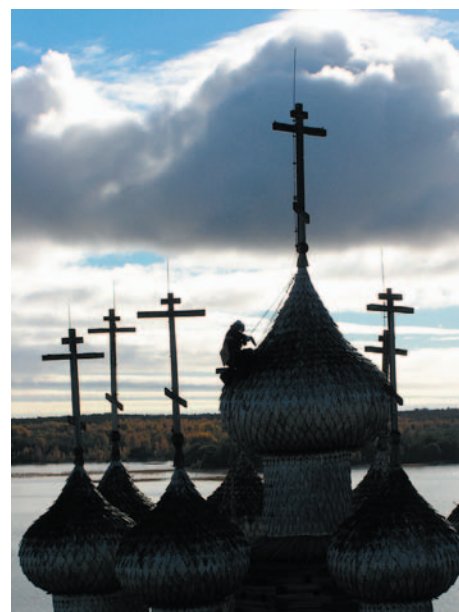
рис. 60. Замена системы молниезащиты на объектах Кижского погоста
