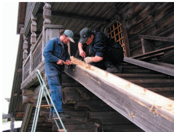
рис. 64. Ремонт косоура лестничного марша крыльца Преображенской церкви
