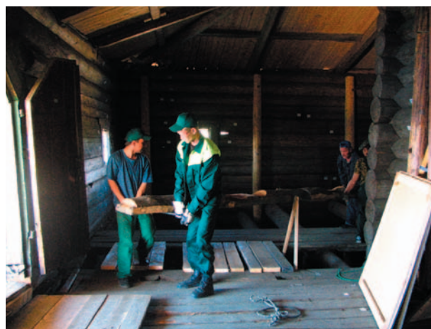
рис. 54. Демонтаж исторических полов XVIII-го века в трапезной Преображенской церкви
