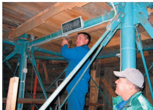
рис. 42. Монтаж внутренней системы пожарной сигнализации и электроосвещения
