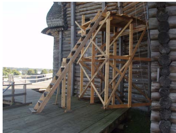
фото 6. Вспомогательные конструкции для монтажа лифтинга
