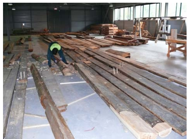
фото 11. Общий вид сборочного участка с раскладкой полов церкви для реставрации
