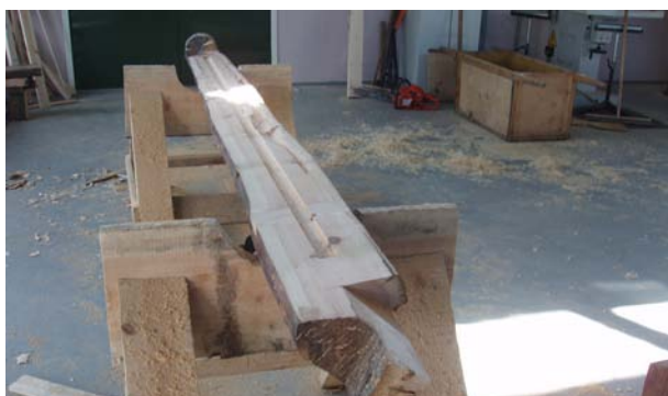
фото 18. Выполнение коронок на бревнах и использованием длинных внутренних шпонок
