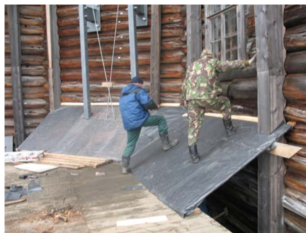
фото 8. Процесс консервации поперечных фундаментов на зиму
