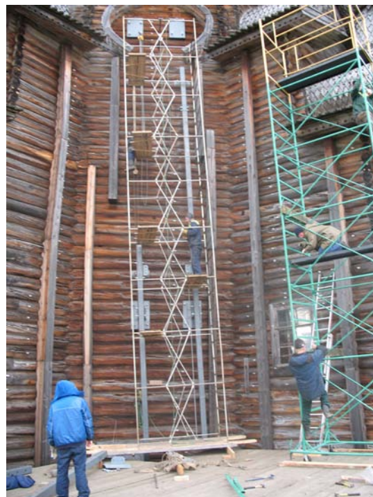
фото 4. Процесс монтажа стоек вывешивания церкви
