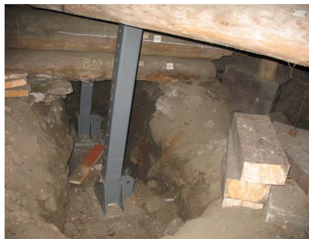
фото 7. Процесс монтажа систем лифтинга на поперечных фундаментах Преображенской церкви
