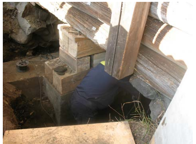
фото 24. Выполнение поперечных фундаментов под диагональными стенами восьмерика церкви
