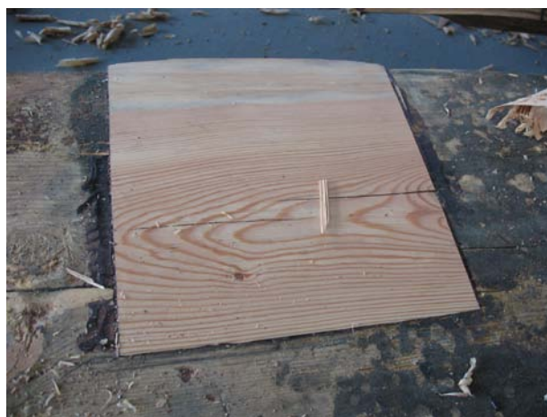
фото 20. Вставка из нового материала - замена разрушенного участка
