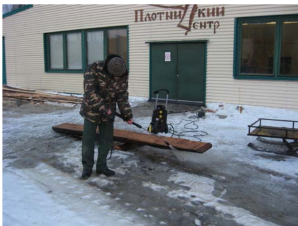
фото 21. Процесс очистки полов с помощью аппарата подачи воды высокого давления
