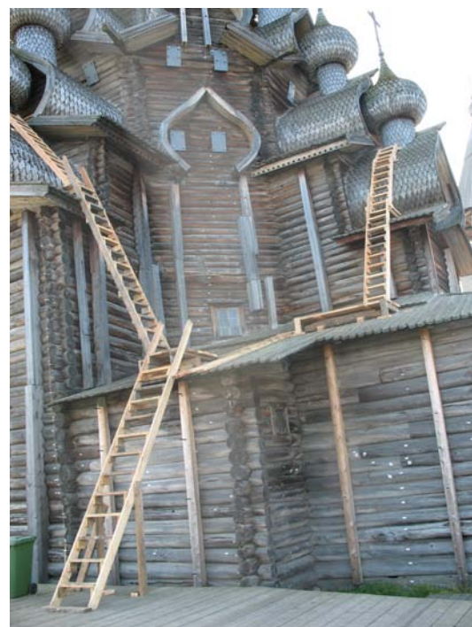
фото 5. Вспомогательные конструкции для монтажа лифтинга
