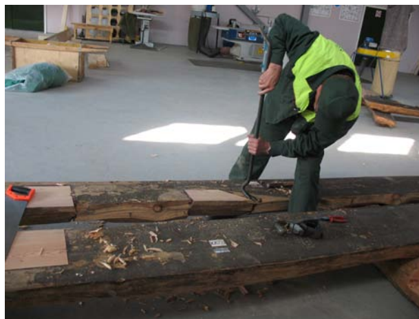
фото 19. Реставрация исторических полов
