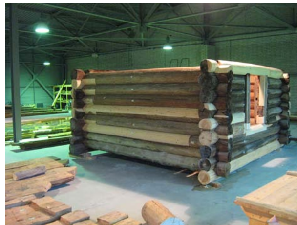
фото 16. Сборка отреставрированной части сруба амбара в сборочном цехе реставрационного комплекса
