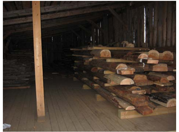
фото 22. Укладка отреставрированных элементов полов в штабеля до проведения реставрации на погосте
