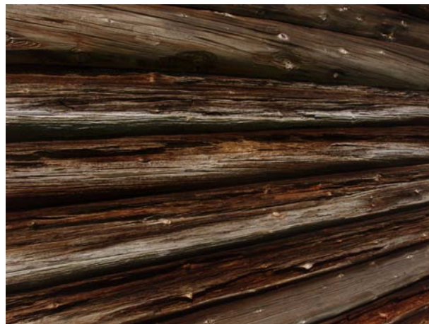
фото 15. Деструктурированная древесина амбара, вид с восточной стороны амбара
