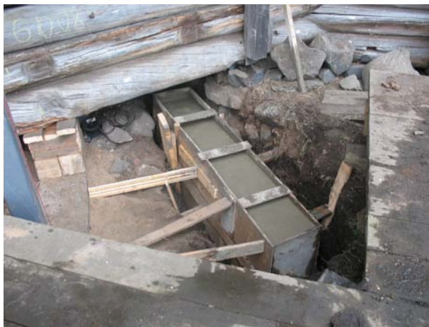
фото 23. Выполнение поперечных фундаментов под диагональными стенами восьмерика церкви
