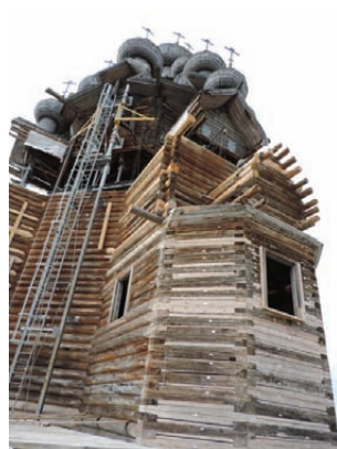
Сборка V технологического пояса на погосте
