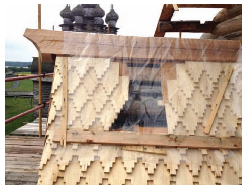
Изготовление полиц и покрытия бочки алтарной главки церкви
