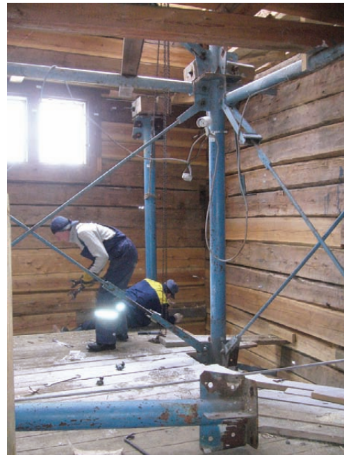
Демонтаж стоек силового каркаса в прирубках церкви
