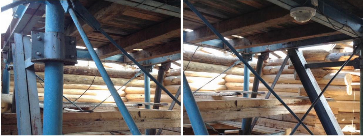
Устройство компенсирующих связей
