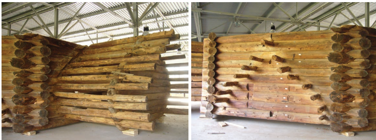
Сруб III технологического пояса. Предварительная сборка в цехах
