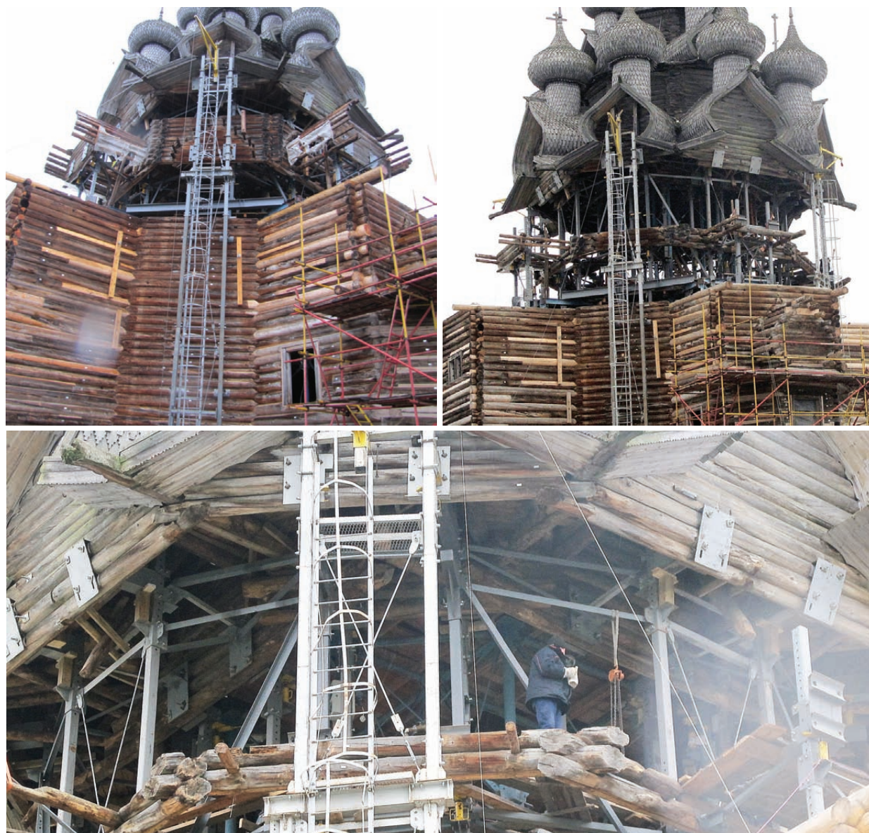
Процесс демонтажа III технологического пояса
