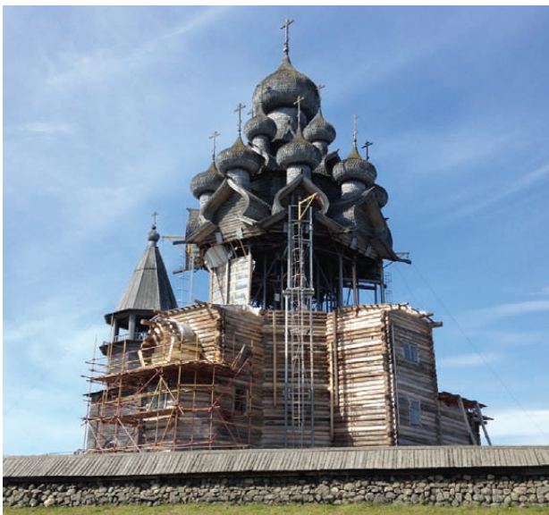
Вид церкви после демонтажа III технологического пояса
