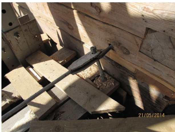
Стягивание прирубных стен талрепами и деревянными сжимами
