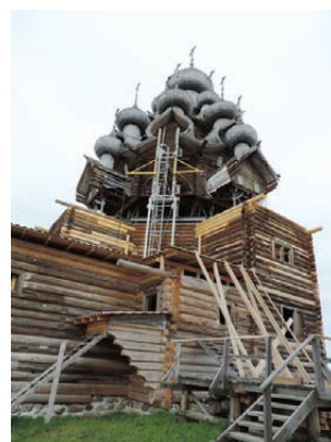
Стягивание прирубных стен талрепами и деревянными сжимами
