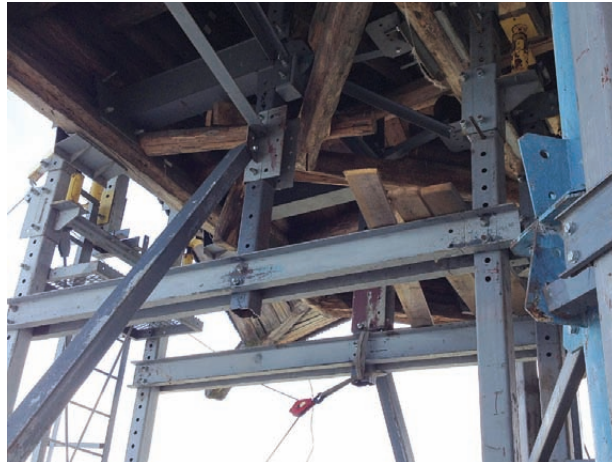
Перемонтированы конструкции лифтинга, поддерживающие верхнюю часть ввешенной части церкви
