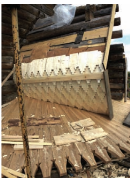
Изготовление полиц и покрытия бочки алтарной главки церкви
