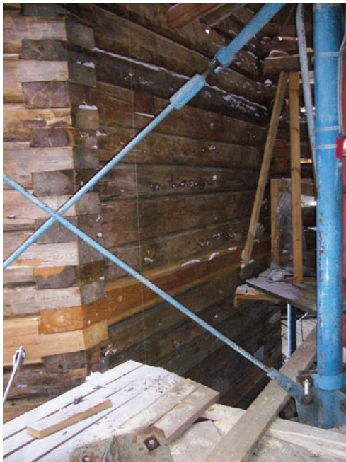
Северо-восточная стена церкви. Демонтированы стойки лифтинга у диагональных стен
