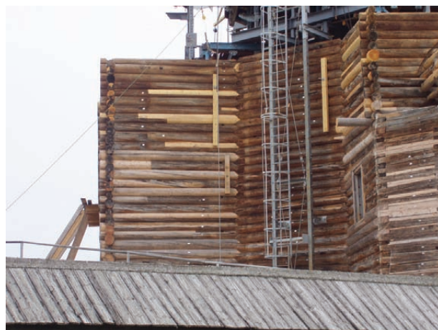
Стягивание прирубных стен талрепами и деревянными сжимами
