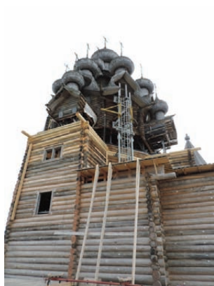
Сборка V технологического пояса на погосте
