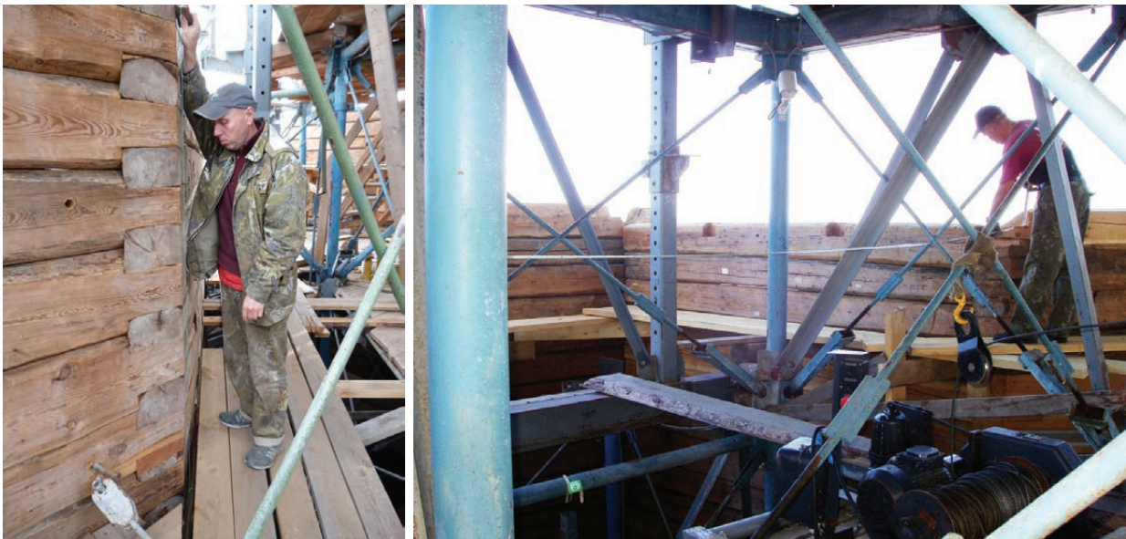
Замеры состояния сруба при сборке на погосте
