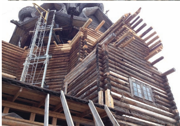
IV технологический пояс, смонтированный на погосте
