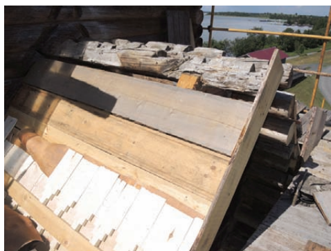
Изготовление полиц и покрытия бочки алтарной главки церкви
