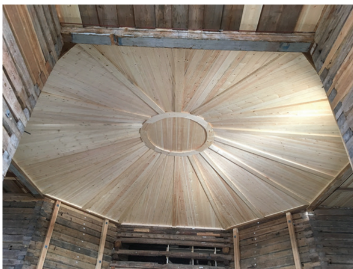
Смонтированная конструкция потолка «небо» в храмовой части церкви
