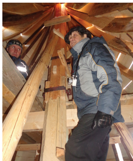
В. С. Рахманов внутри центральной главы церкви в ходе проведения авторского надзора на погосте
