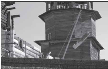
Вид на сруб церкви с лесами
