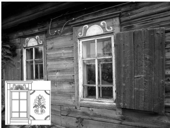
Рис. 3. Наличники с росписью и трехгранно-выемчатой резьбой. Село Бураново Тогульского района. Экспедиция 2007 г. Фотография и прорисовка росписи ставни автора.
